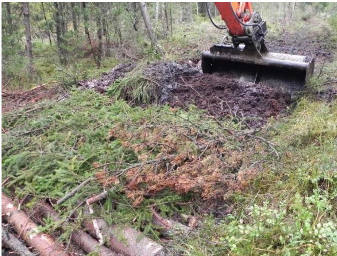
Abbildung 2: Bau eines Knüppelweges mit Torf- und Vegetationsabdeckung
