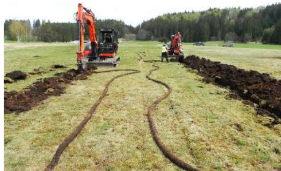
Foto: Rückbau von Drainagesträngen auf einer Streuwiese bei Seeg mit dem Ziel, den moortypischen Wasserhaushalt und die darauf angepasste artenreiche Vegetation wiederherzustellen
