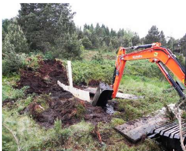
Foto: Bau einer Spundwand mit Torfummantelung
