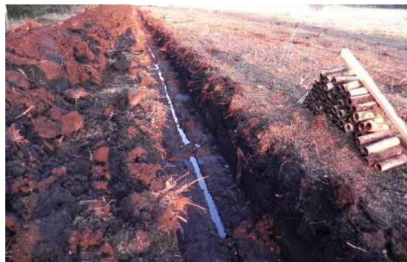
Foto: Rückbau von Tondrainagen auf einer stark degradierten Streuwiese bei Stötten
